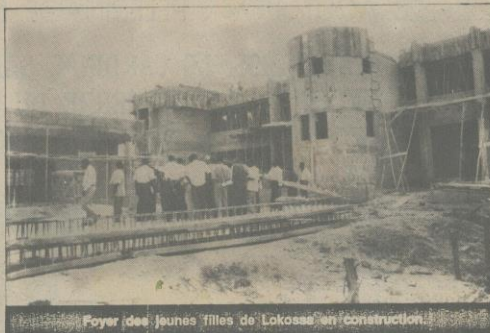
Foyer des jeunes filles de Lokossa en construction
