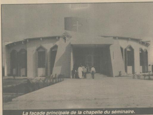
La façade principale de la chapelle du séminaire.
