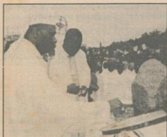
Pose de la première pierre du sanctuaire en construction par Son Eminence le cardinal Ganin.
